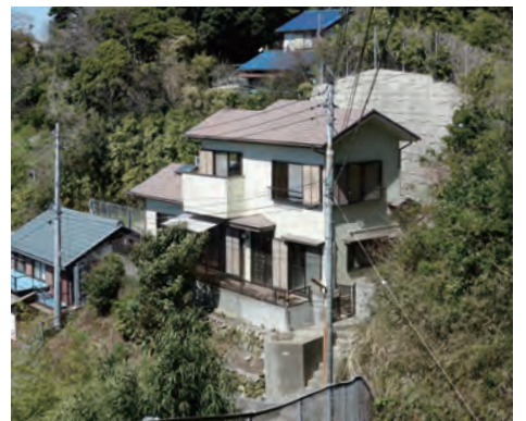
▲階段道路が入り組んだ高台の立地。車も横付けできないため、工事用の資材を運ぶのも一苦労です。
